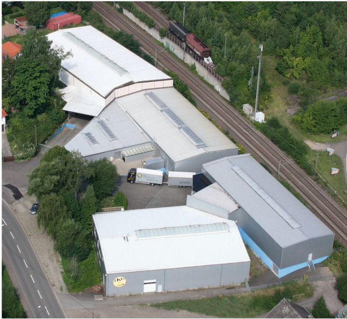
IKO Hauptbetrieb - IKO main warehouse
