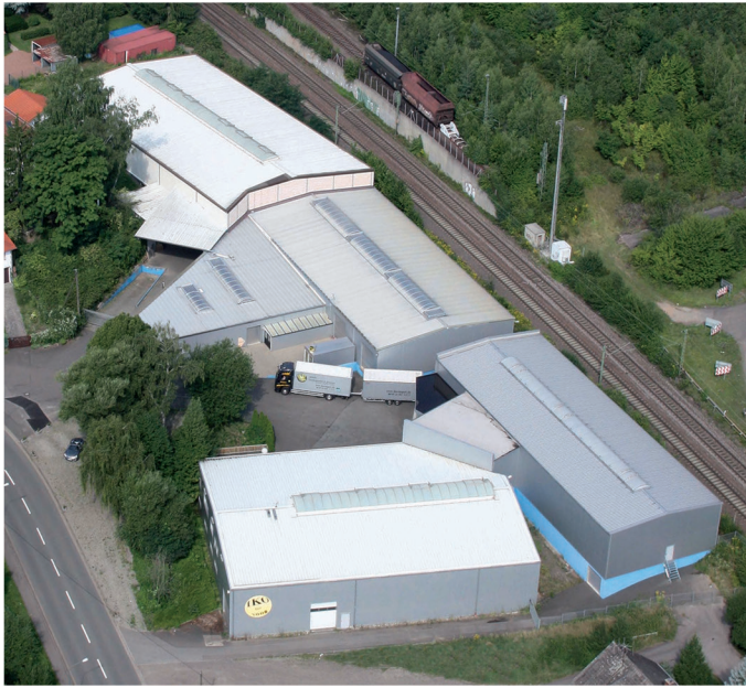
IKO Hauptbetrieb - IKO main warehouse
